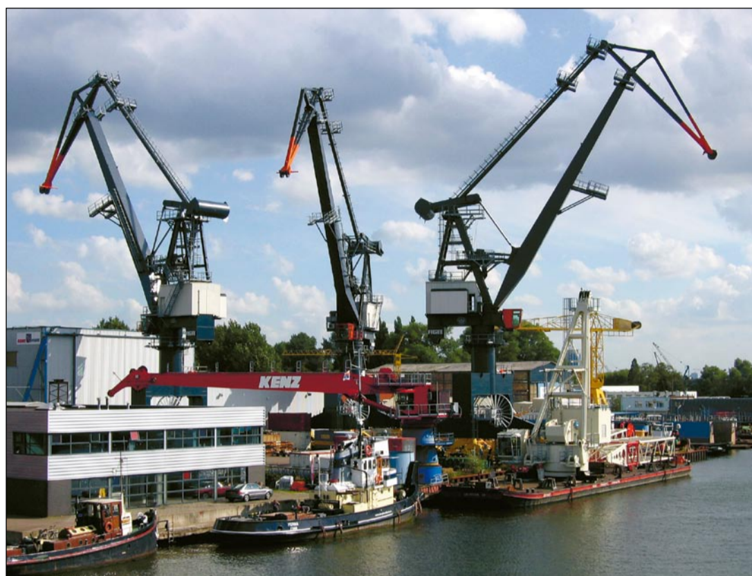
De 'test & commissioning area' van Kenz aan de Zaan, waar de kranen beproefd worden
